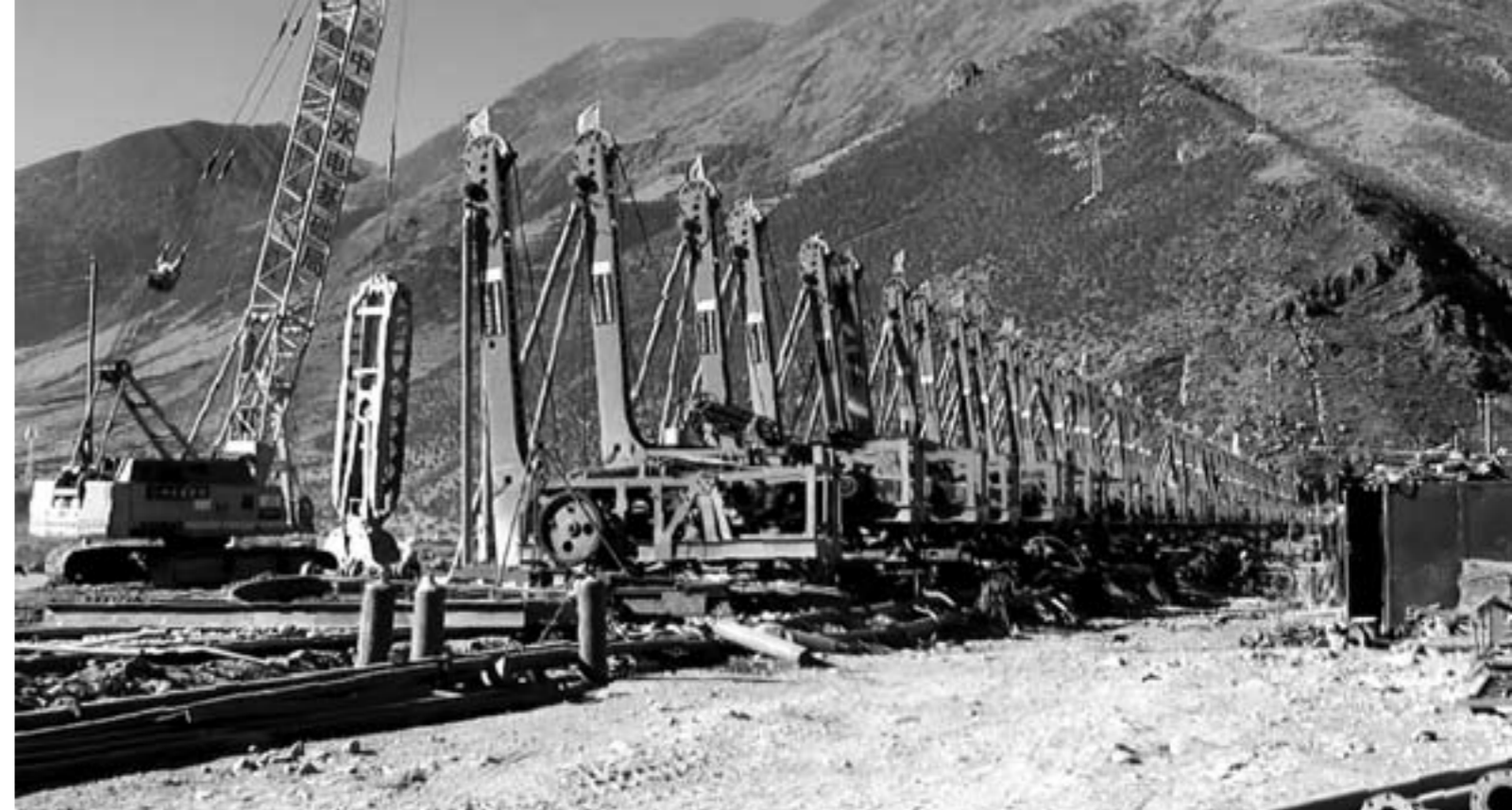
Etablering af hydroelektrisk anlæg, der skal levere energi til mineraludvinding i Lhundrup distrikt © Vivi Walter
